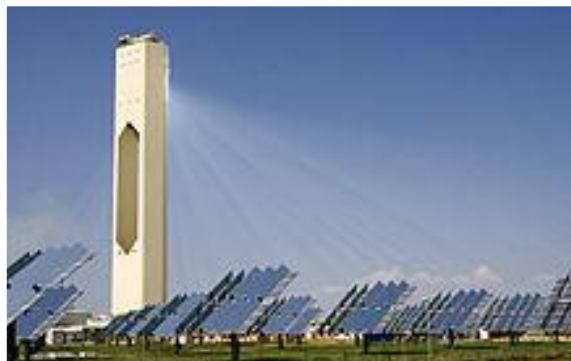
شکل ۱۲- نیروگاه دریافت کننده مرکزی (Power Tower)
