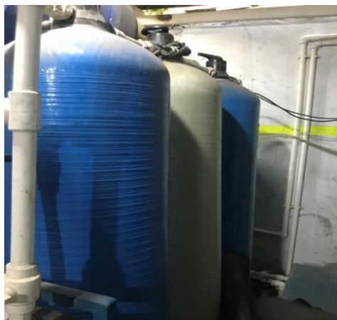
شکل ۲: فیلترهای سیلیس، رزین و کربن
